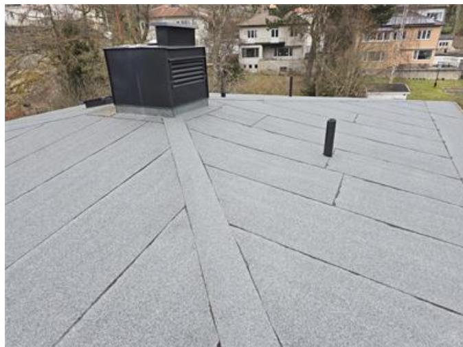
Överblick del av yttertak.
