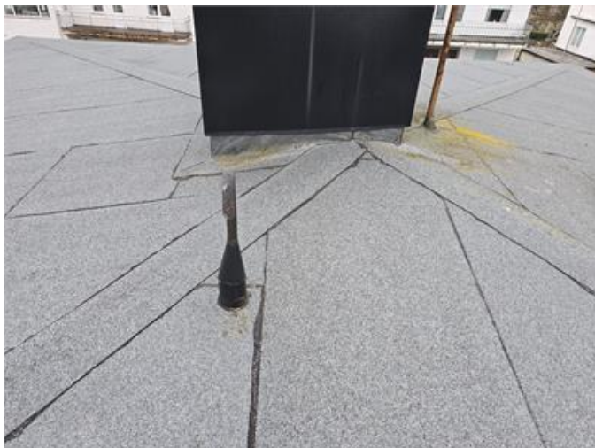
Överblick del av yttertak.
